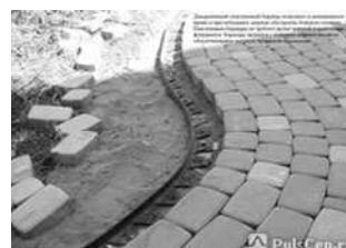
Рис. 4.17. Укладка садового бордюра
