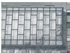
Рис. 1.73. Облицовка здания стеклопакетами
